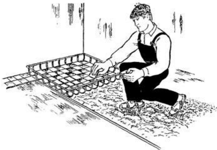
Рис. 12 . Настилка пола с помощью клеточного шаблона
